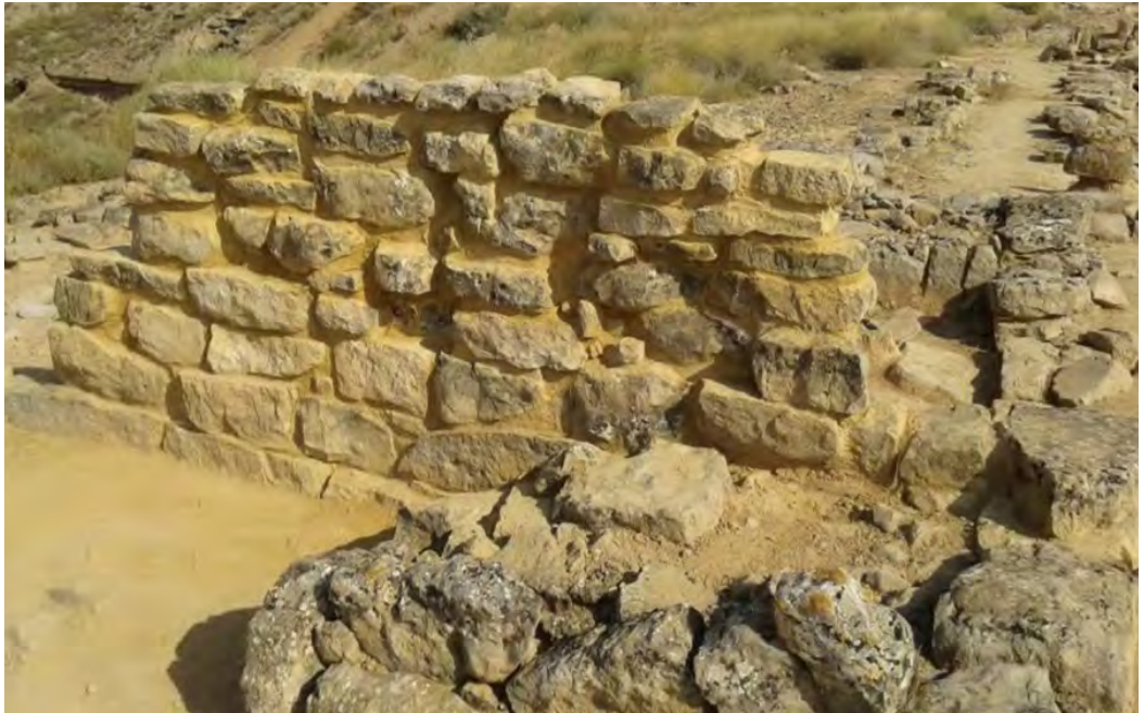
Figura 5. Resultado de la intervención en el muro caído y reconstruido por anastilosis. Paramento sur. Autor: David Rodríguez.
